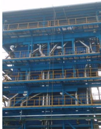
余热锅炉现状
