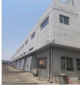
危废暂存库现状
