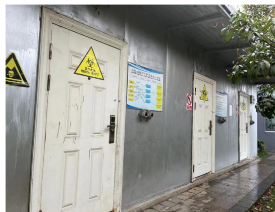
百家汇危废库图片
