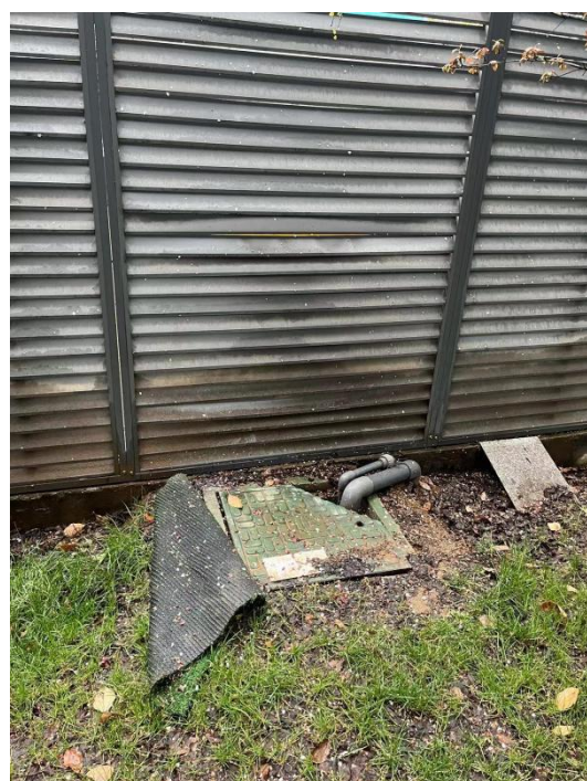
百家汇污水与处理站
