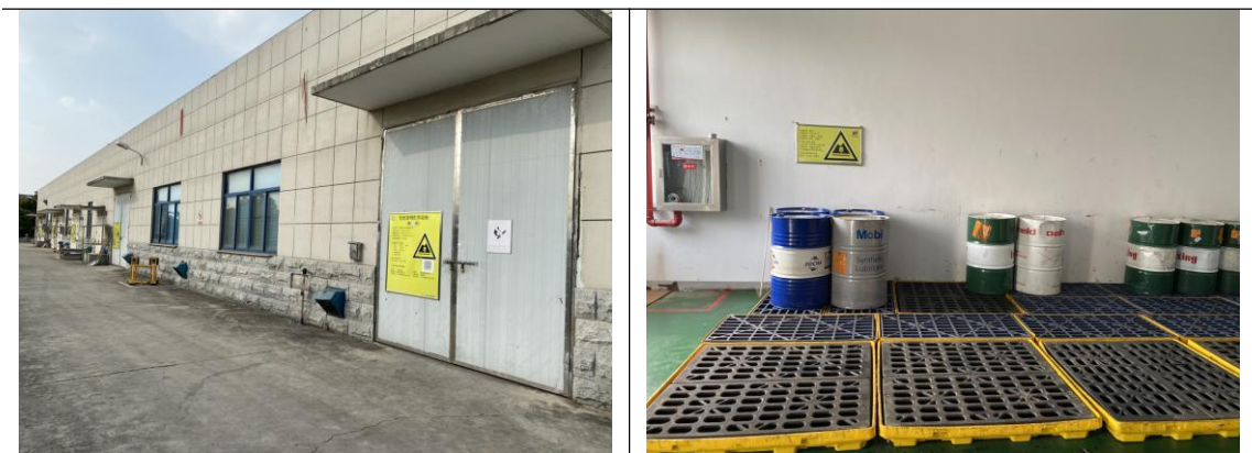
图 5-2 厂内现有危废仓库
