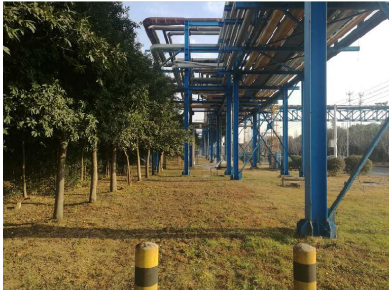
方水东路管廊
